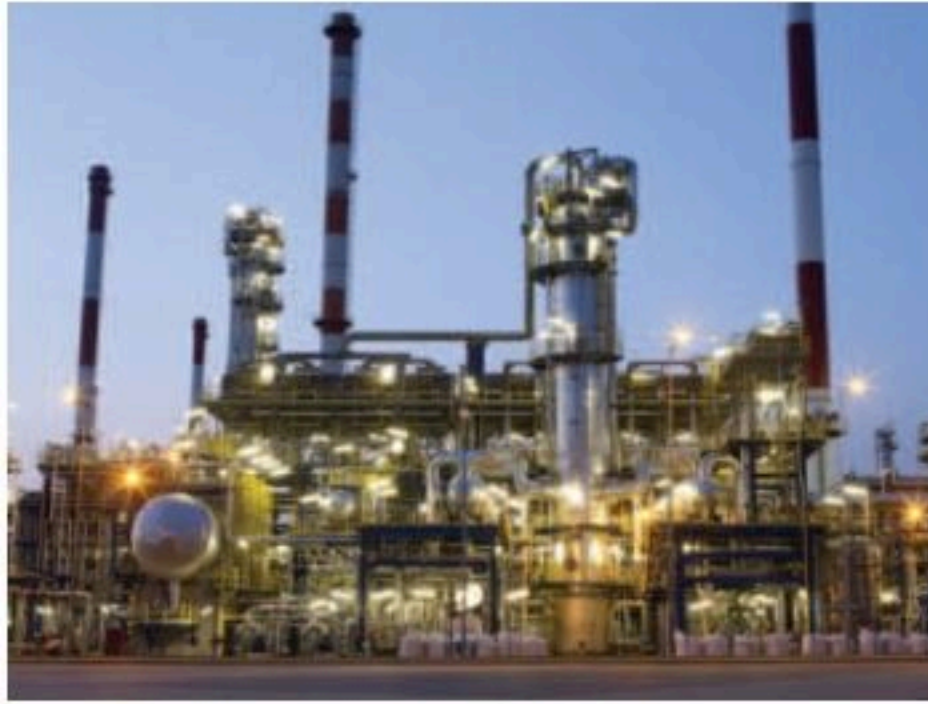
محطة توليد الكهرباء في الجبيل
